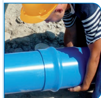
Dar un empujón firme y seco con el tubo cuyo cabo se va a introducir en la copa para de esta forma aprovechar la inercia del tubo. Introducir el cabo hasta que se oculte la marca.
