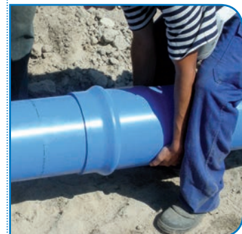
Alinear la tubería e introducir el bisel en la entrada de la copa.
