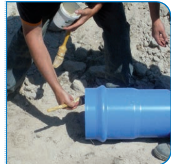
Aplicar lubricante en el bisel del cabo y en la junta de la embotadura.
